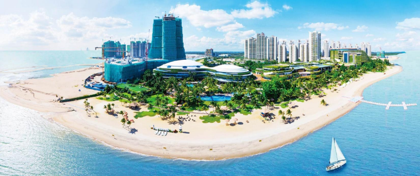
Actual Photo 实景图
